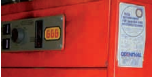
Bild 5.1.9-4: Gasbetriebener direkt beheizter Trinkwarmwasserspeicher
