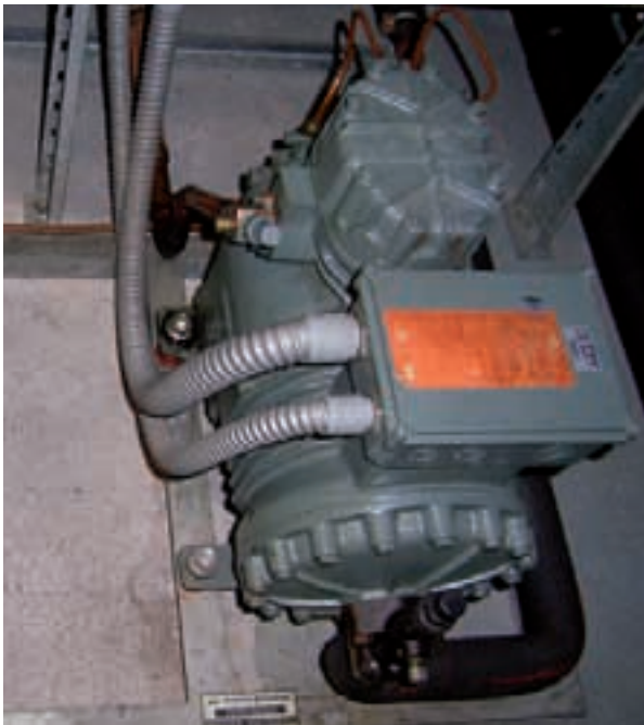
Bild 5.1.8-11: Kolbenverdichter
