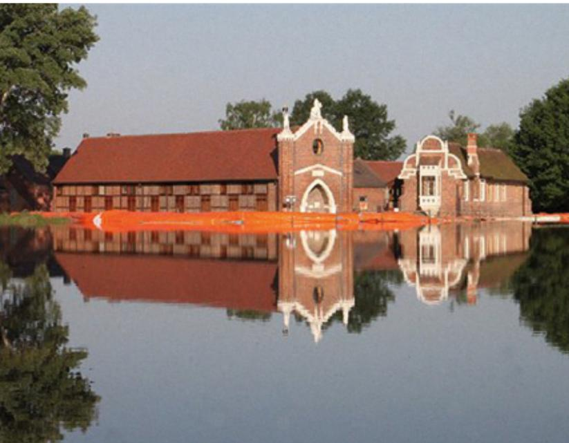
Objektschutz mit mobilem wassergefülltem Schlauchsystem
