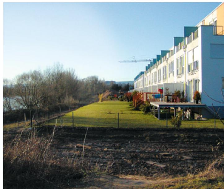
Hochwasserangepasste Bauweise mit erhöhtem Erdgeschoss
