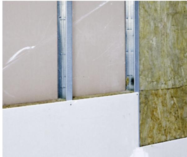
Nichttragende Metallständerwände mit Dämmstoff und Beplankungen aus Gipsfaserplatten
