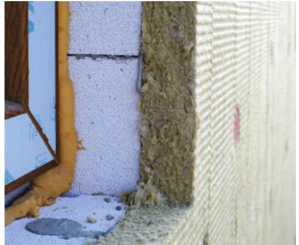
Einsatz von Mineralfaserplatten als Außenwanddämmung
