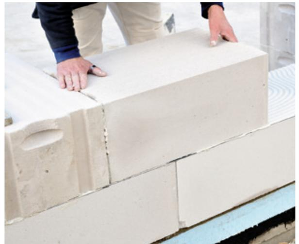
Mauerwerk aus Porenbeton-Plansteinen
