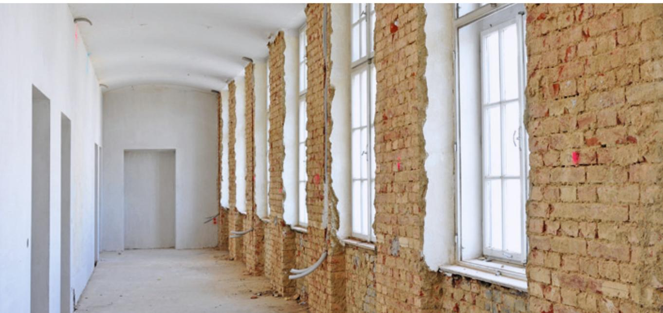
Entfernter Putz zur besseren Trocknung einer Außenwand
