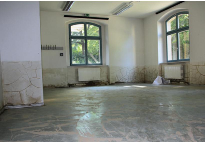
Durchfeuchtete und verschmutzte Außenwände nach Überflutung
