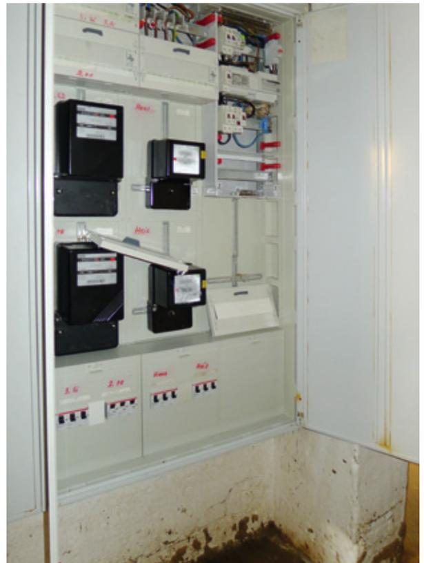
Überfluteter Sicherungsasten in einer Erdgeschosswohnung
