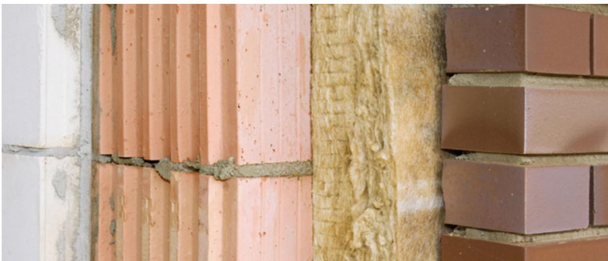
Bei mehrschaligen Außenwandkonstruktionen ist die durchfeuchtete Dämmstoffsicht nur sehr schwer zugänglich.
