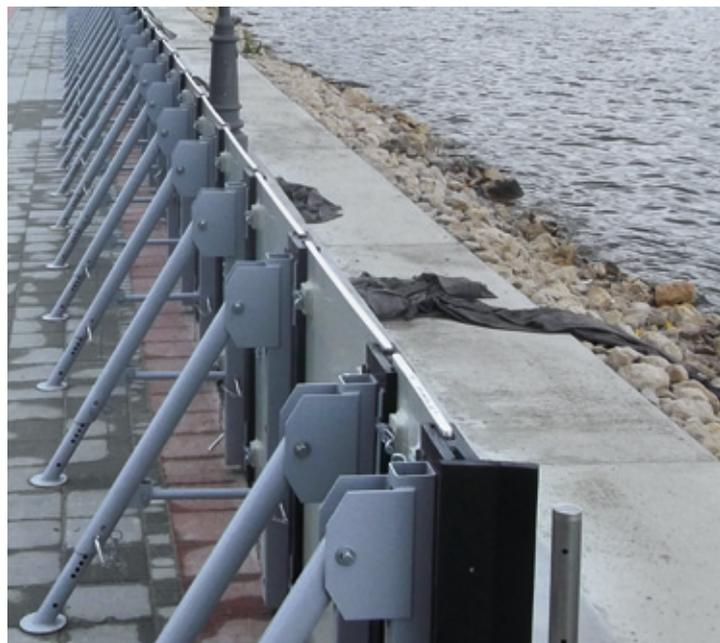
Hochwasserschutz mit Hochwasserschutzplatten aus Kunststoff
