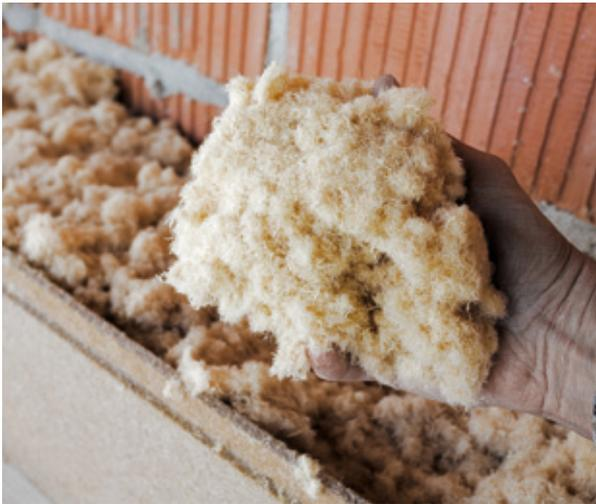
Holzweichfasern für die formatvariable Wärmedämmung von Hohlräumen
