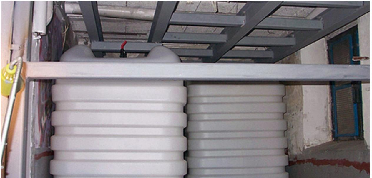
Heizöltankanlage mit Auftriebssicherung
