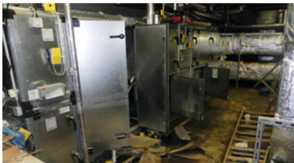
Viele Anlagenteile von Lüftungs- und Klimaanlage sind nach einer Überflutung auszutauschen
