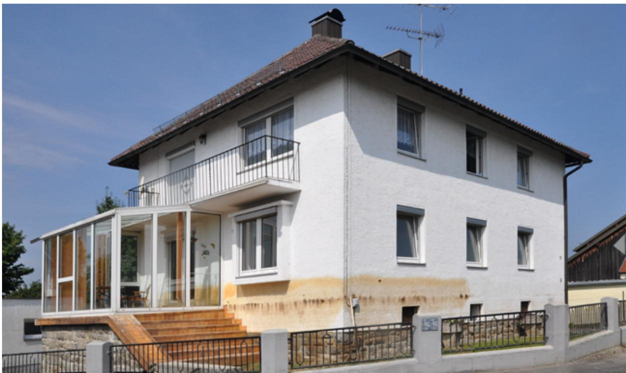
Mit Heizöl belastetes Wärmedämm-Verbundsystem eines Wohnhauses
