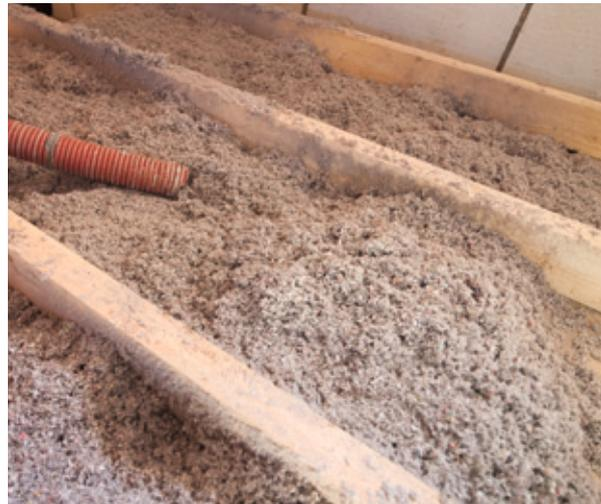
Anwendung von Zelluloseflocken im Fußbodenbereich
