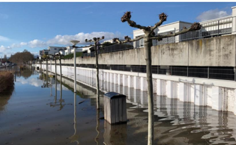
Hochwasserschutzwand mit eingerammter Stahlspundwand
